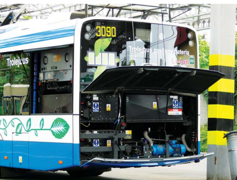
Fot. 3. Tylne drzwi trolejbusu Solaris Trollino 12; widoczne są 3 moduły baterii (czarne skrzynki) oraz układ ładowania (szara skrzynka w górnej części aparatury)
